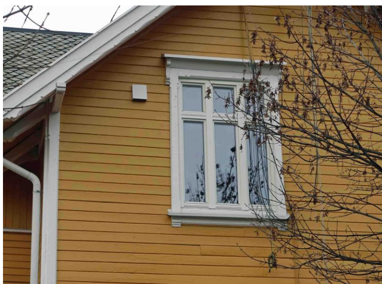
Vindu og polstret kappe i gavlvegg
